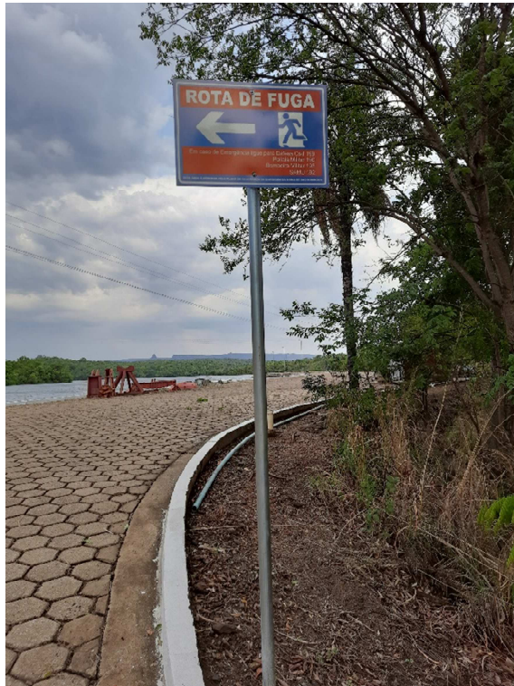
Figura 27 – Placa da rota de fuga da margem direita, próxima à subestação.
