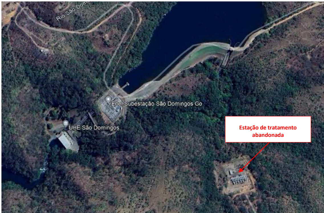
Figura 39 – Estruturas abrangidas pela mancha de inundação da Usina São Domingos.
