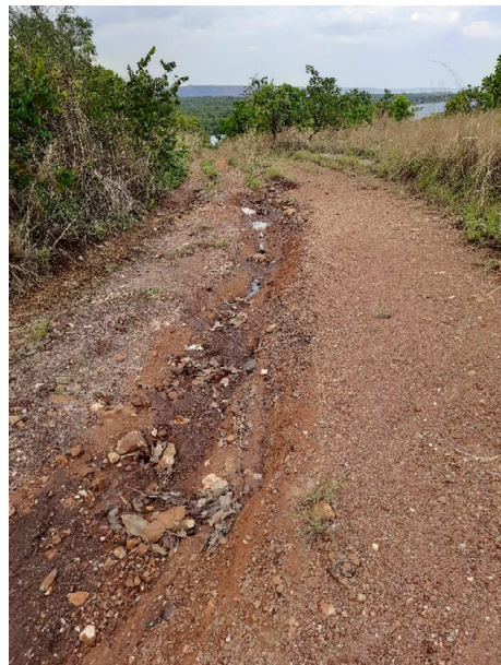
Figura 13 – Estrada de acesso à Usina São Domingos pela margem direita.
