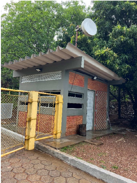
Figura 15 – Vista da parte externa da sala de emergência.
