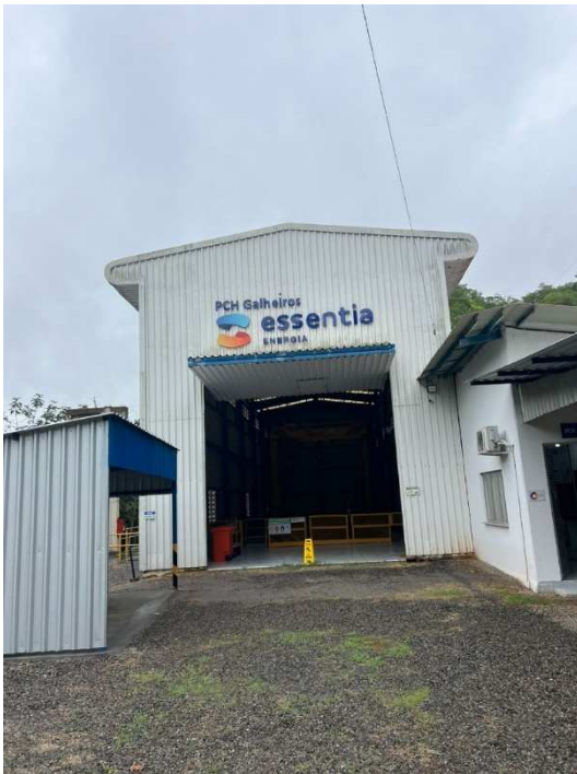
Figura 37 – Casa de força da Usina Galheiros.
