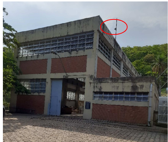
Figura 22 – Sirene instalada na casa de força.
