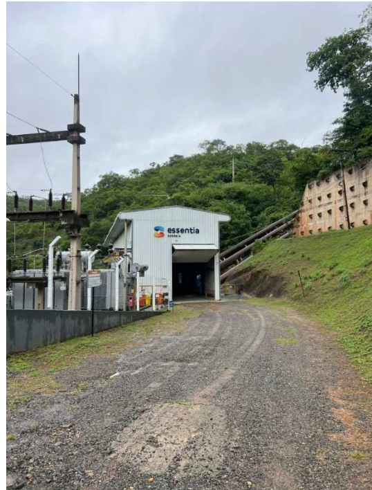
Figura 38 – Casa de força da Usina São Domingos II.
