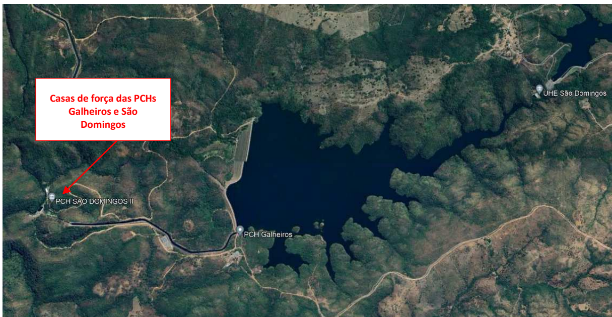
Figura 40 – Estruturas abrangidas pela mancha de inundação da Usina São Domingos.
