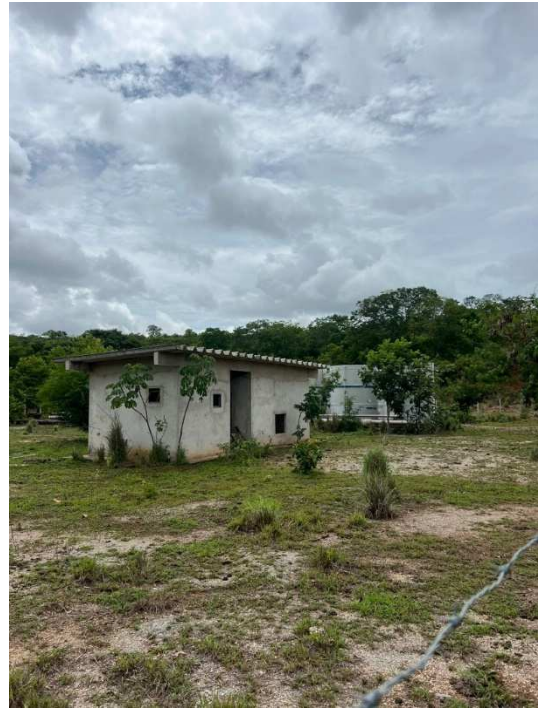
Figura 36 – Estação de tratamento inacabada da prefeitura.
