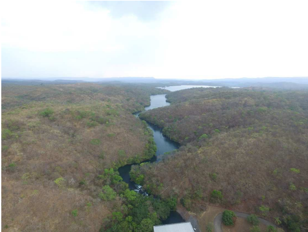
Figura 31 – Início do vale de jusante, no trecho entre o canal de fuga da Usina São Domingos e a barragem da Usina São Domingos II.
