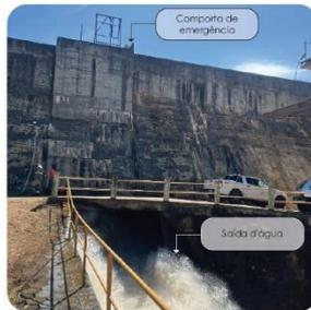
Figura 4: Vertedouro de Emergência com duas comportas da PCH Rochedo
